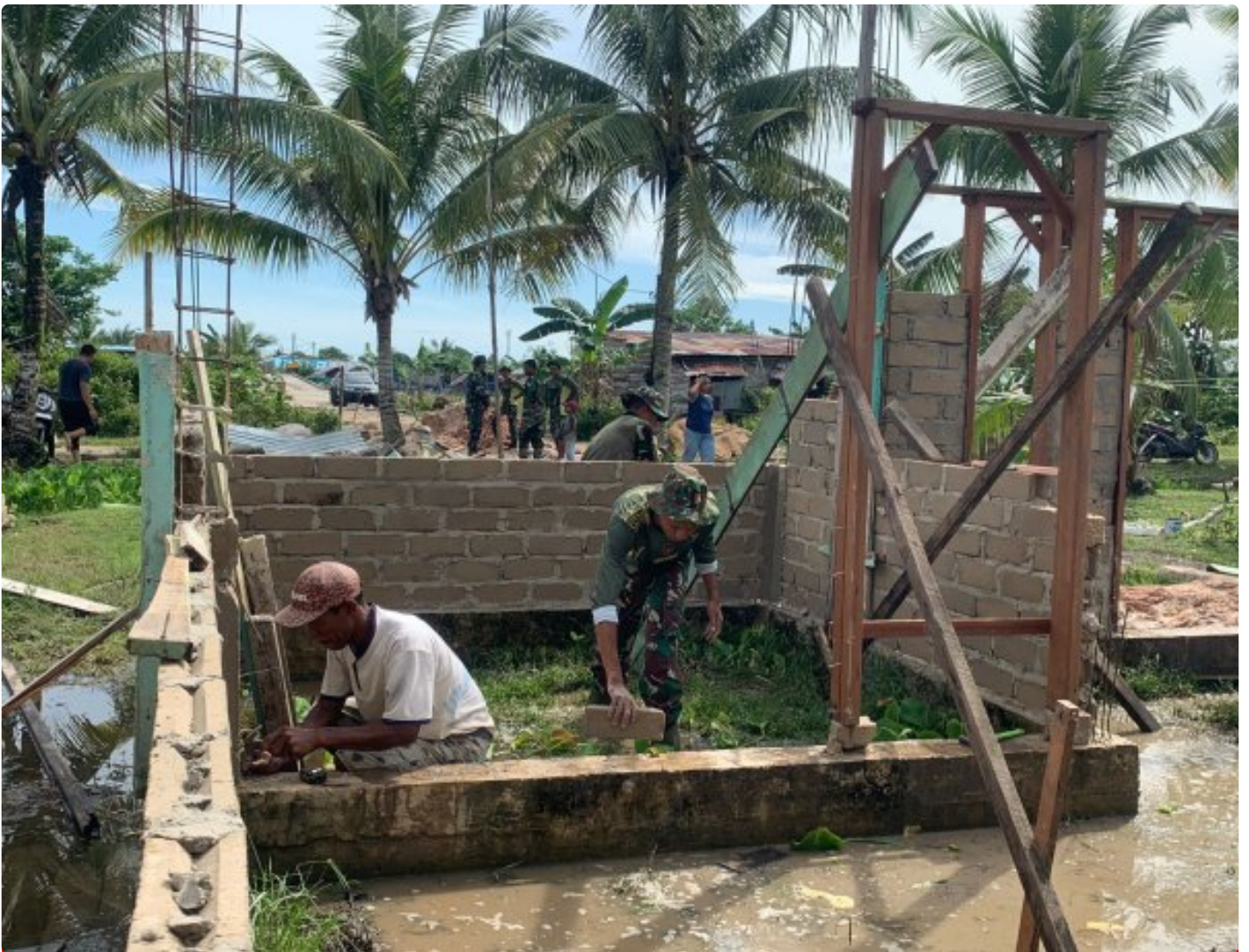
Serma Karno: Tak Ada Kata Lelah, Rehab RTLH Terus Dikebut
